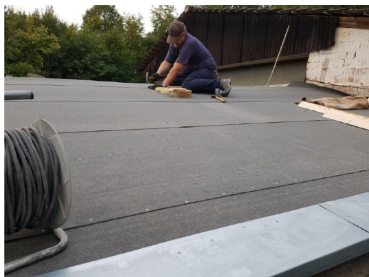
Aufbringen der neuen Dachabdeckung
