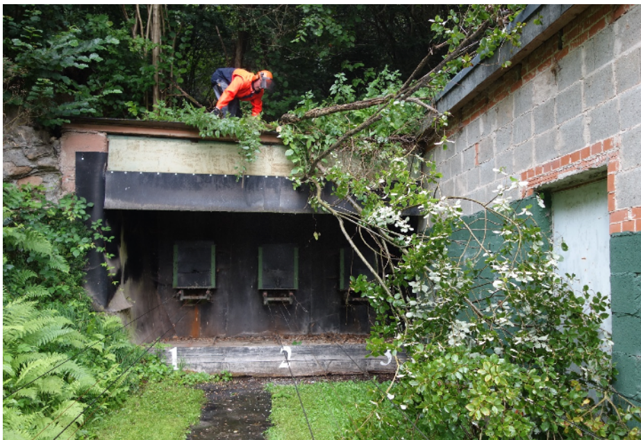
Beseitigung von Windbruch in der Schießbahn
