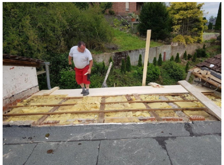
Vorbereitung für die neue Dachabdeckung
